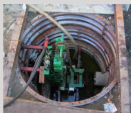
到達立坑内の引込み装置(LW56)
